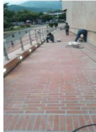
Imagen 24. Terminación de la obra impermeabilización rampa puerta 3
