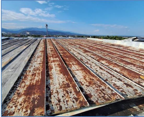
Cubierta oxidada y con goteras
